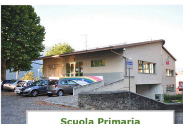
Scuola Primaria di Ponte in Valtellina
